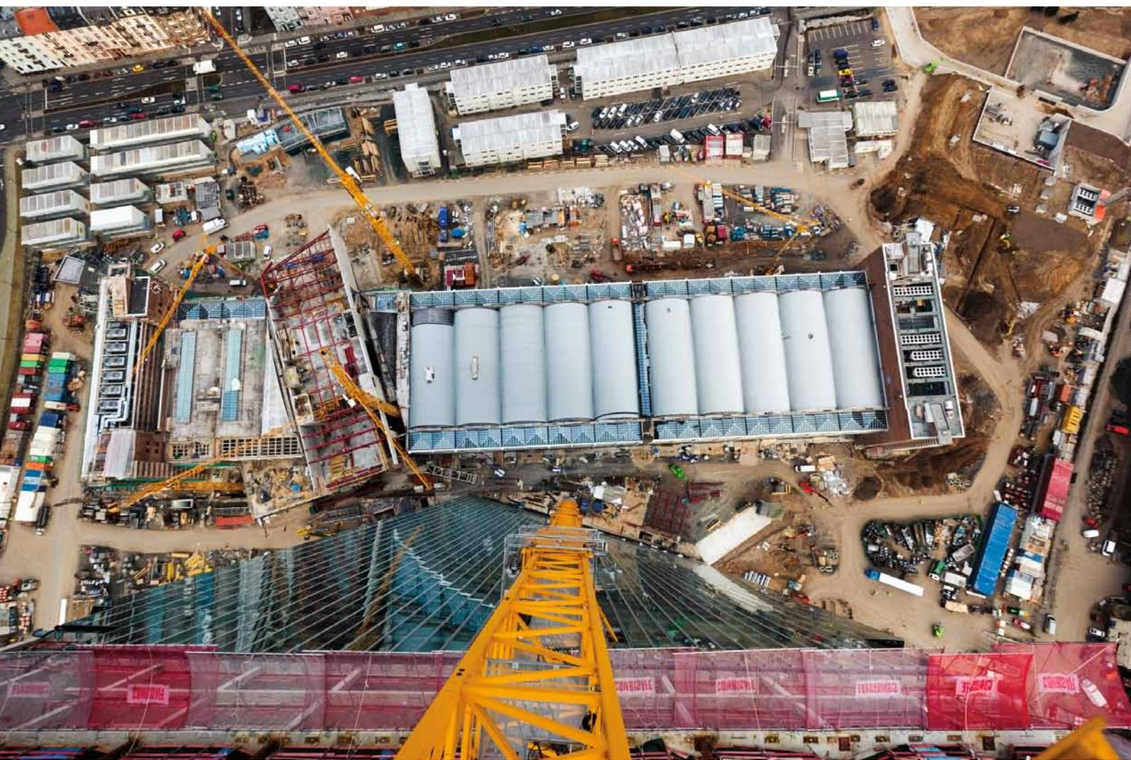
Im Berichtsjahr schritten die Arbeiten auf der Baustelle des EZB-Neubaus sichtbar voran. Im Frühjahr wurden die Rohbauarbeiten aller neuen Gebäudeelemente abgeschlossen, zum Jahresende waren außerdem die Wiederherstellungsarbeiten am Tonnenschalendach der Großmarkthalle beendet. Auch das Innere der geräumigen Markthalle erstrahlt nun in neuem Glanz.
